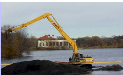
Back hoe, removing sediment out of Como Lake, 2001
